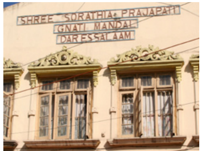
Détail du "Shree Sorathia Prajapati Gnati Mandal", bâtiment de la communauté Hindou sur "Upanga Road" (photo : K.Moon).
